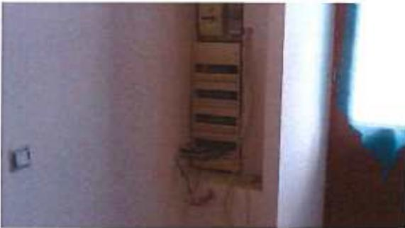
**Au moins un CONDUCTEUR isolé n'est pas placé sur toute sa longueur dans un conduit, une goulotte, une plinthe ou une huisserie, en matière isolante ou métallique, jusqu'à sa pénétration dans le MATERIEL ELECTRIQUE qu'il alimente.**
