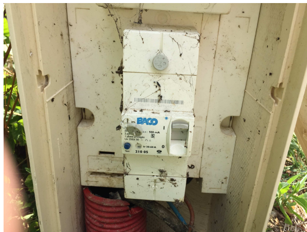
AGCP Extérieur dans une logette
