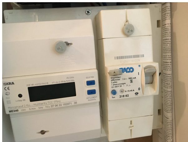
disjoncteur de branchement
