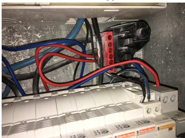
**L'installation électrique comporte au moins une CONNEXION avec une partie active nue sous tension accessible.**
