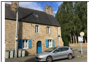
Photo générale de l'immeuble
